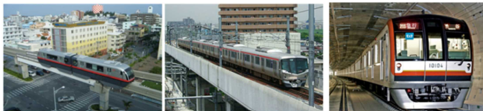
高架橋による専用軌道
